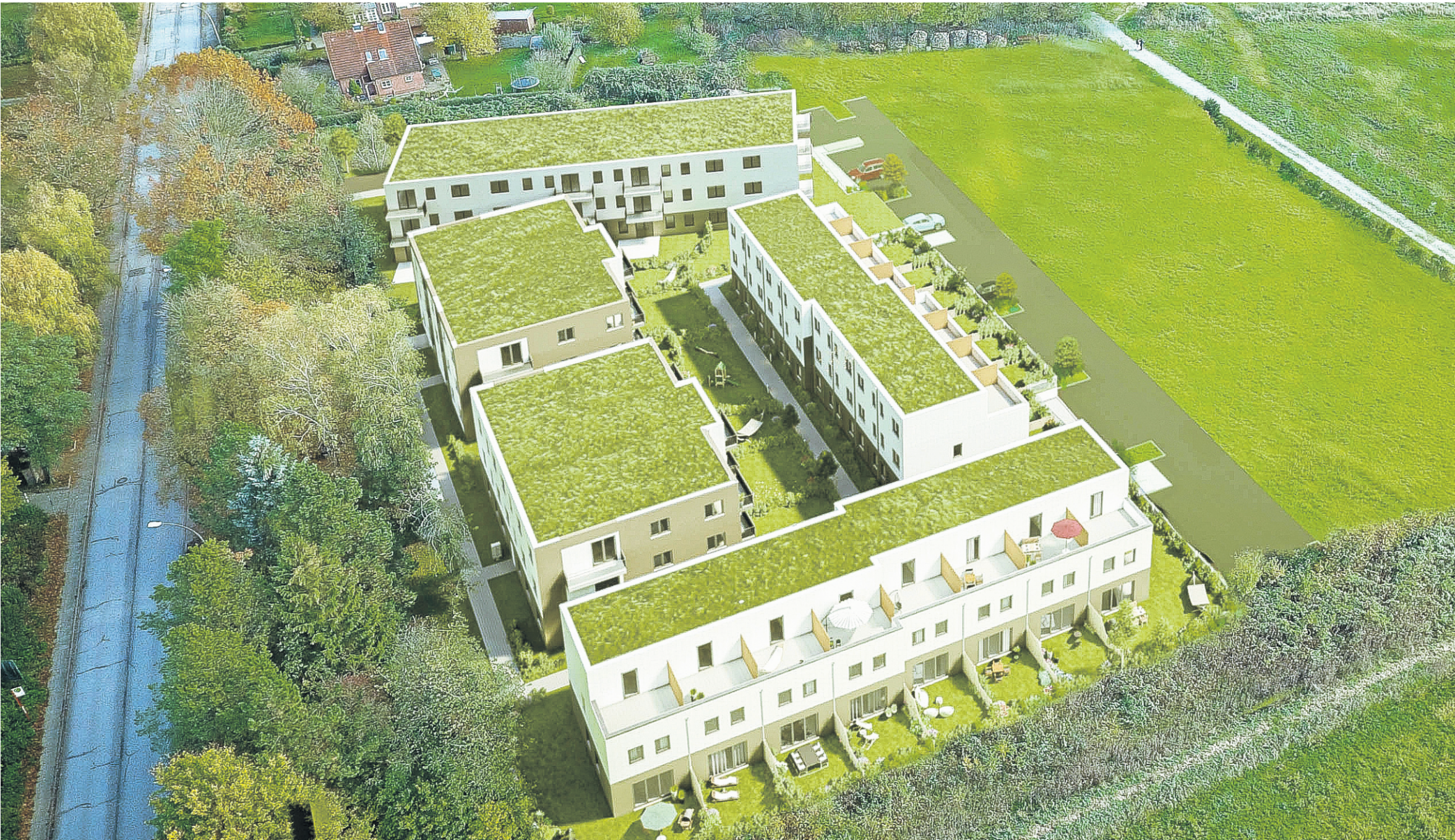
Projekt Ahrmoor: Am Beimoorweg entstehen drei Mehrfamilienhäuser mit 51 Eigentumswohnungen, 16 Reihenhäuser und zwei Gebäude für „stilles Gewerbe“.
